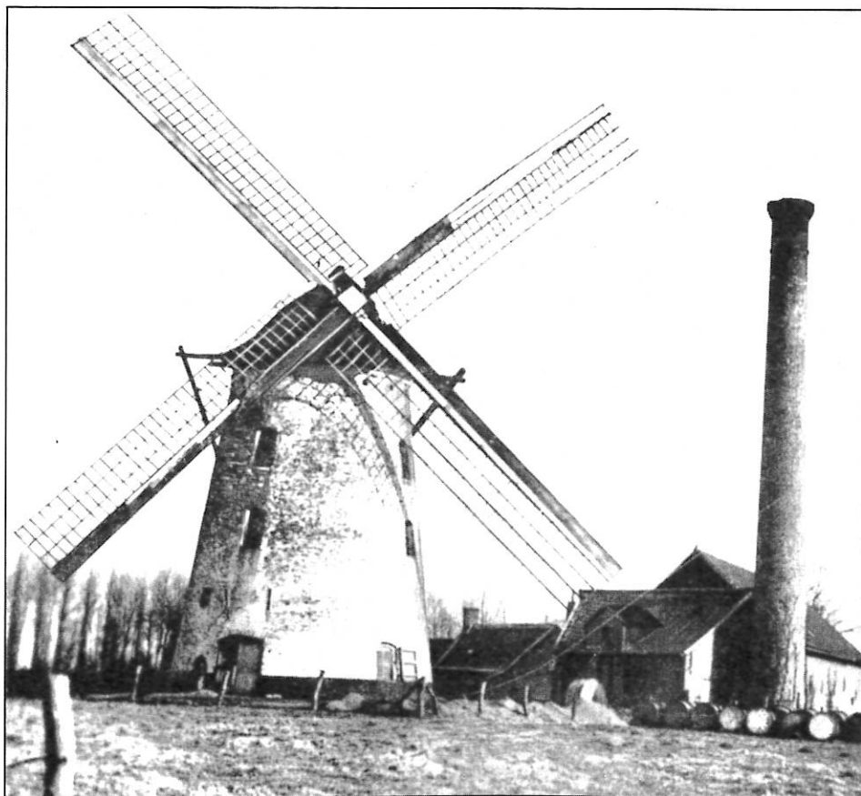
Rumbeke, De Aapmolen (De Brabander), Meensesteenweg, voor 1913 J. De Brabander: Die grote schouw die je ziet op de foto hebben we laten metselen in 1892, toen de stoommachine werd geplaatst. Die schouw zorgde niet alleen voor de nodige trek (luchtstroom, tocht) voor de viering (vuring, stookplaats) van de stoomketel, maar ook werd de rook van 't foernoois (fornuis) van uit de molen langs daar afgeleid. Vroeger ontsnapte de rook zo maar langs de stellingaten in de molen.
