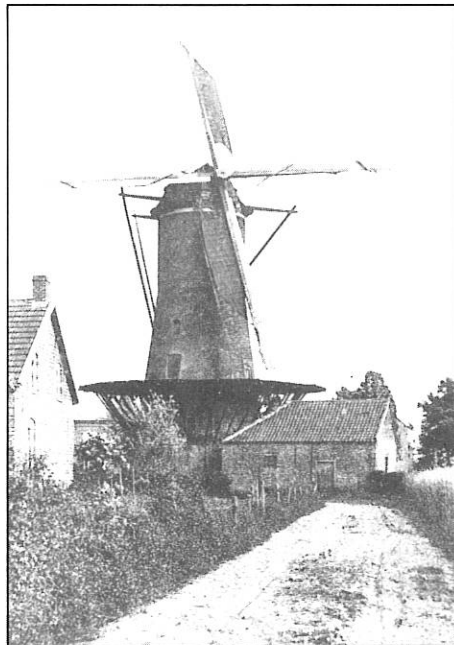
Hamont, "Napoleonsmolen". Ongedateerde foto (vóór 1952); reproductie Geschied- en Heemkundige Kring 'Goede Stede Hamont'. Zicht vanuit het NNW. Het gebouw rechts aan de molen is de olieslagerij.
